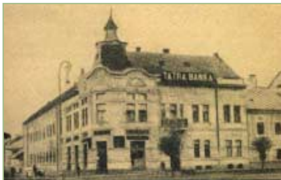
Budova filiálky Tatra banky v Brezne, predtým Breznianskej banky
