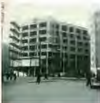
Stavba administratívnej budovy Slovenskej národnej banky v Bratislave (SNA, fond STK, č. 24010) // Construction of Slovenská národná banka's administrative building in Bratislava (SNA, STK fond, No 24010)
