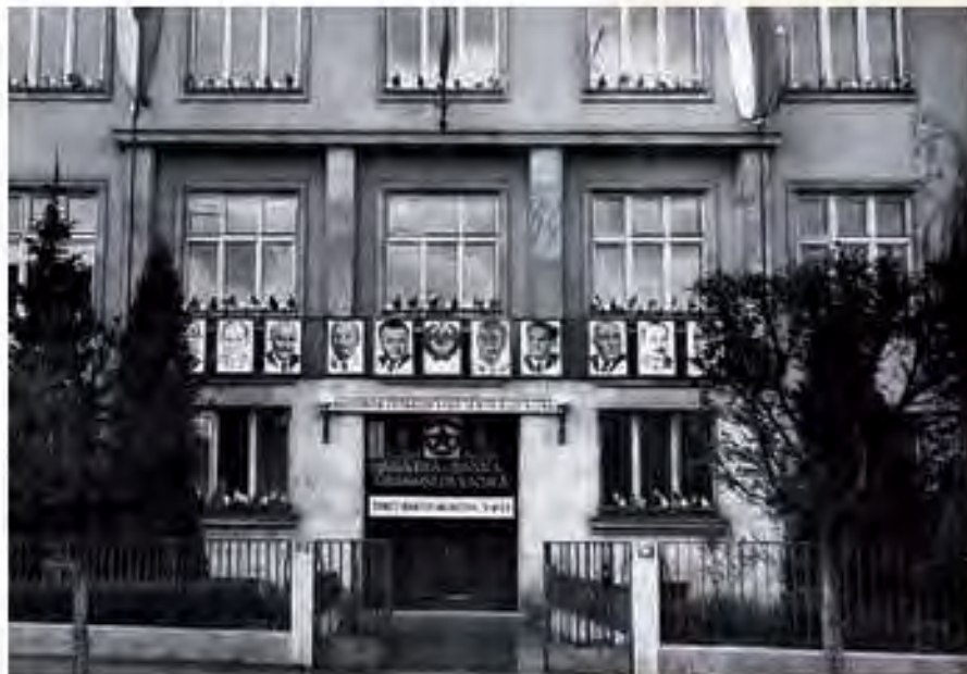
Budova pobočky Štátnej banky československej v Piešťanoch // Piešťany branch of Štátna banka československá
