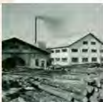
Drevárska firma Čisárík v Turzovke (SNA, fond STK, č. 16787) // Wood-processing company Čisárík in Turzovka (SNA, STK fond, No 16787)
