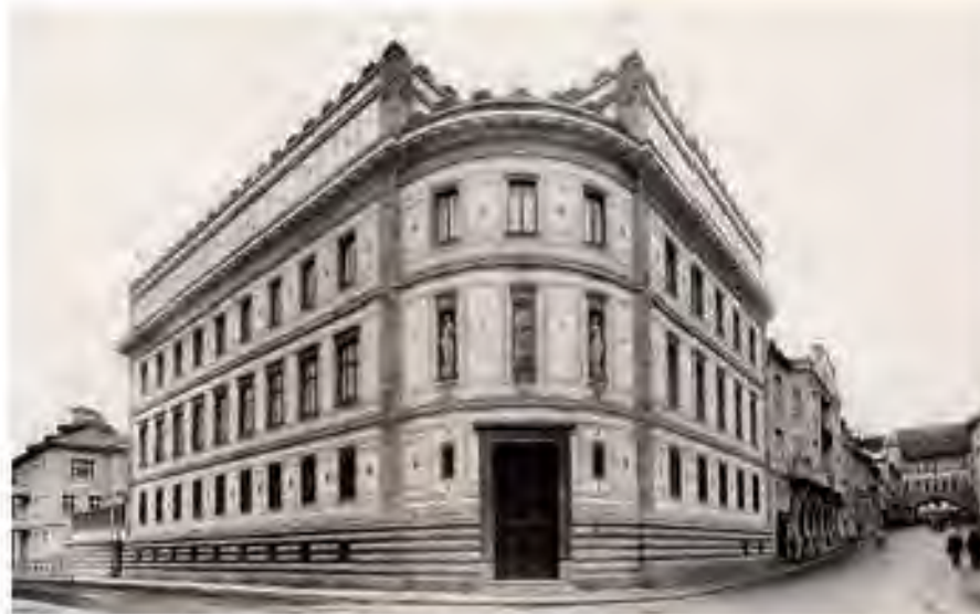
Budova filiálky Národnej banky Československej v Banskej Bystrici postavená v rokoch 1930 – 1932 podľa projektu Ladislava Skřivánka // Building of the Banská Bystrica branch of Národná banka Československá, built from 1930 to 1932 and designed by Ladislav Skřivánek
