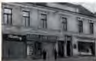
Budova Sedliackej banky v Novom Meste nad Váhom // Building of Sedliacka banka in Nové Mesto nad Váhom
