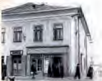
Budova Rolníckej vzájomnej pokladnice v Barde- jove // Building of Rolnícká vzájomná pokladnica in Bardejov
