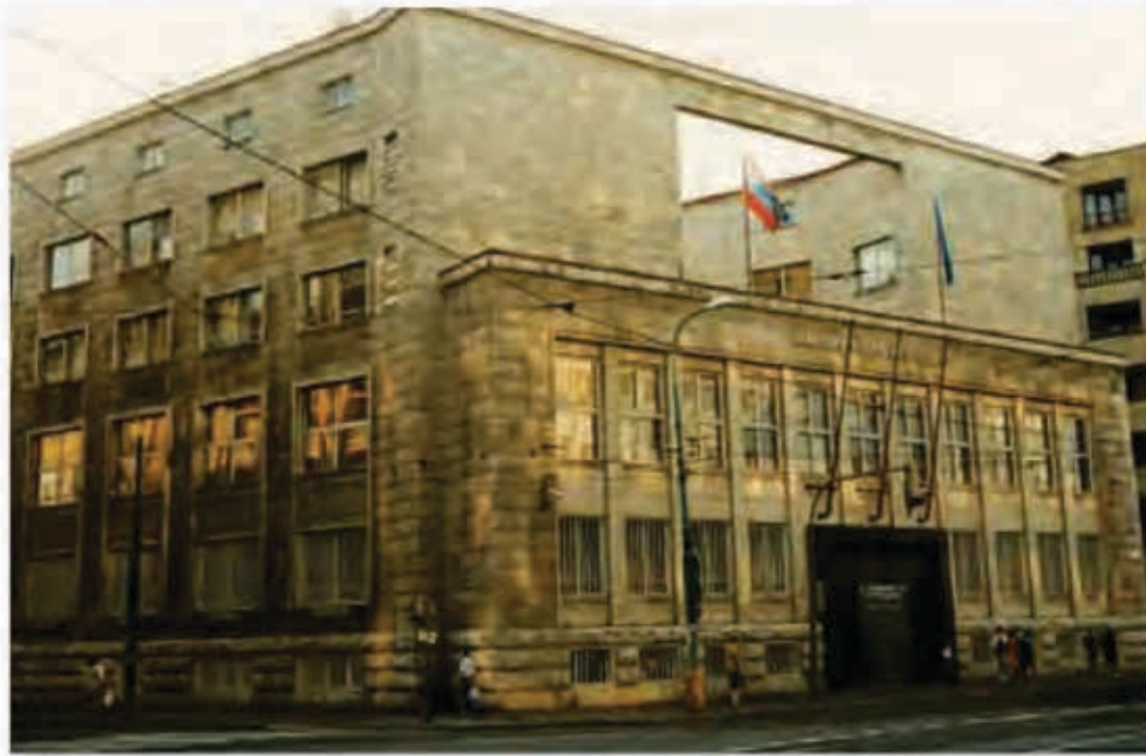
Budova Národnej banky Slovenska na Štúrovej 2 v Bratislave, 1993 // Building of Národná banka Slovenska in Bratislava, 2 Štúrova Street, 1993
