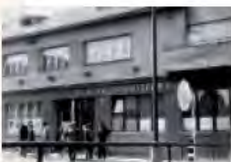
Budova Štátnej sporiteľne v Bánovciach nad Bebravou // Building of Štátna sporiteľňa in Bánovce nad Bebravou
