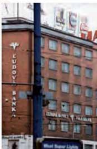
Budova Ludovej banky – Volksbank v Bratislave na Námestí Slovenského národného povstania (1994) // Building of Ludová banka – Volksbank in Bratislava, SNP Square, 1994
