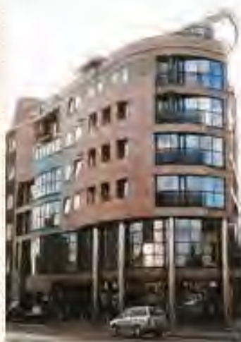
Budova Slovenskej sporiteľne na Suchom Mýte v Bratislave (1999) // Building of Slovenská sporiteľňa in Bratislava, Suché Mýto Street, 1999
