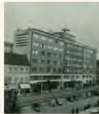
Budova Ústredného družstva na dnešnom Námestí Slovenského národného povstania v Bratislave (SNA, fond STK, č. 2307) // Building of the Central cooperative in Bratislava, at what is now SNP Square (SNA, STK fond, No 2307)
