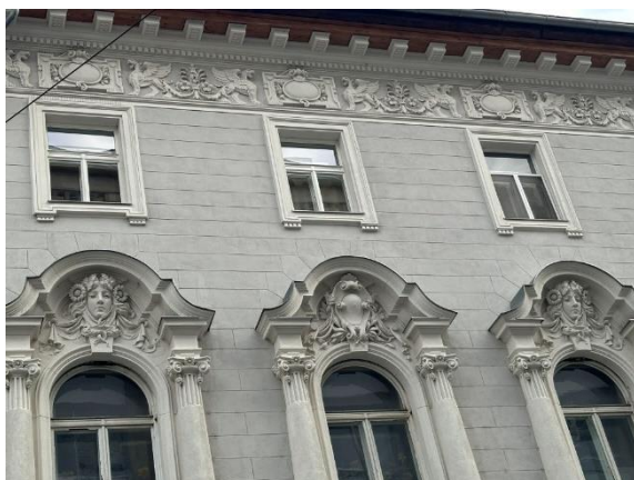
Obr. 4a, 4b a 4c: Súčasná podoba budovy na Štúrovej ulici č. 6 v Bratislave, 2024
