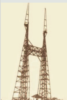
▲ Anténový stožiar Murgašovej vysielacky vo Wilkes-Barre The antenna mast of Murgaš's wireless station in Wilkes-Barre
