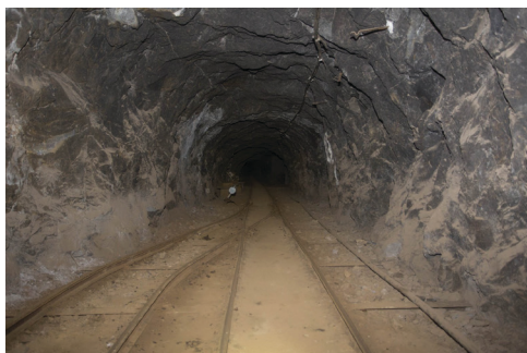
◀ Hlavná dedičná štôlňa pod elektrárnou
