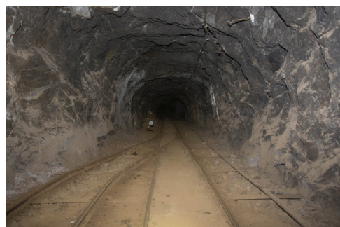
◀ Hlavná dedičná štôlňa pod elektrárnou
